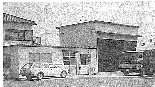
社名/有限会社ビソー環境 所在地/愛知県豊橋市神野新田町字タノ割66-2 代表者/金海 敏 創業/昭和61年 従業員/12名 TEL./0532(32)7468 事業所/本社、安城営業所 営業種別/収集運搬、中間処理(破砕) 取扱い品目/燃え殻、汚泥、廃油、廃酸、廃アルカリ、廃プラスチック類、紙くず、木くず、繊維くず、動植物性残渣、ゴムくず、金属くず、ガラスくず及び陶磁器くず、鋳さい、建設廃材、ダスト類、引火性廃油、感染性産業廃棄物、特定有害廃石綿等
