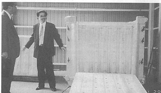
コンクリート型枠脱型
