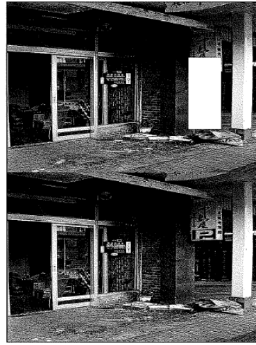
被災写真 2-4 落下した吹付材(小千谷市)
