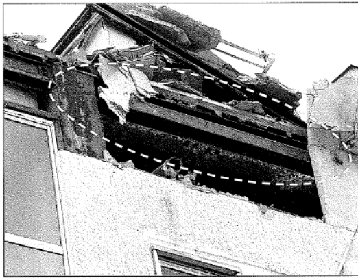
被災写真 2-1 某建物(小千谷市)
