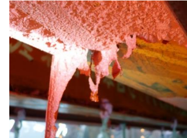
写真 橋梁塗膜除去工事の状況
