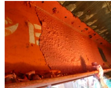
写真 橋梁塗膜除去工事の状況
