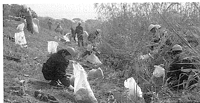
日光川河口戸田茶屋排水機場南でのごみの撤去作業
