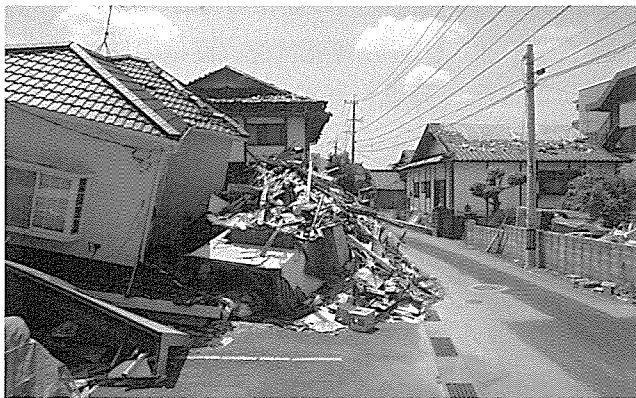
益城町の倒壊した家屋
