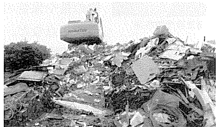
田んぼに接した敷地に土砂など解体廃棄物が不適正保管
