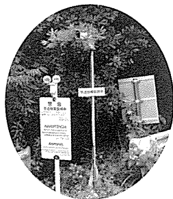
監視カメラの設置を確認
