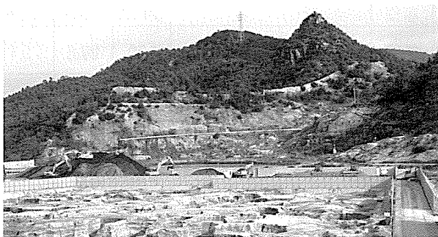
撤去がほぼ終わろうとしている不法投棄現場
