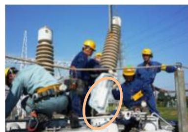
図 9. ブッシングの養生例
