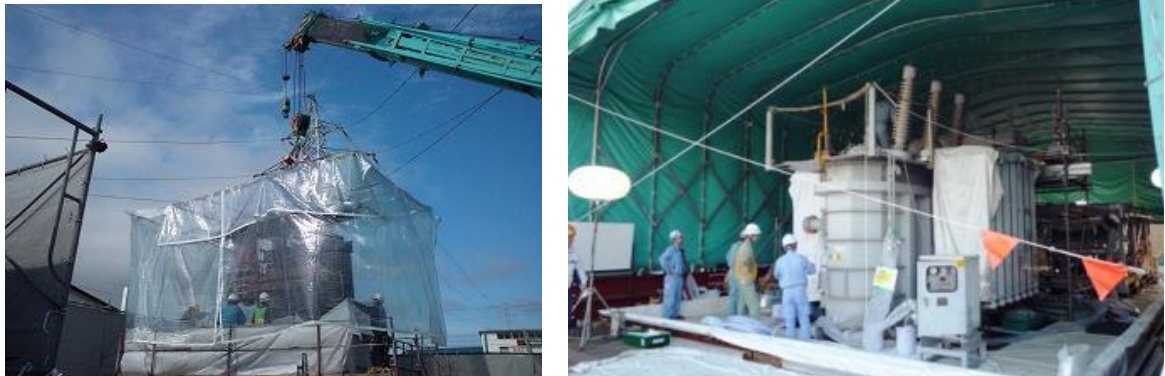
図 10. 養生テントの設置例（左：仮設テント、右：テントハウス）
