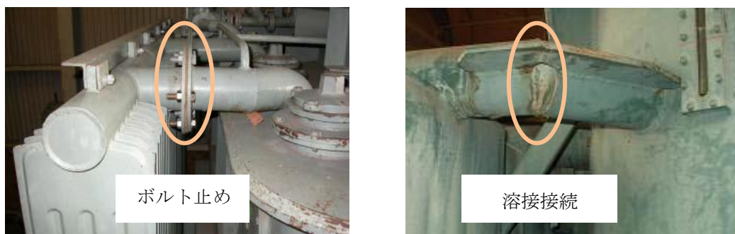
図 8. 放熱器と筐体との接続例
