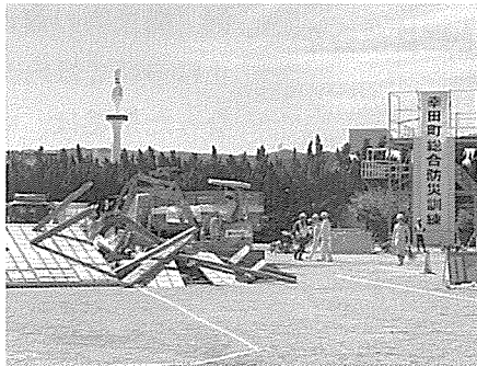
重機によるガレキの除去
