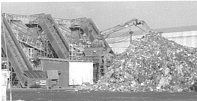
重機による一次選別処理施設への投入の様子
