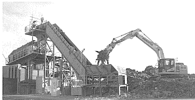
重機による前処理施設への投入の様子
