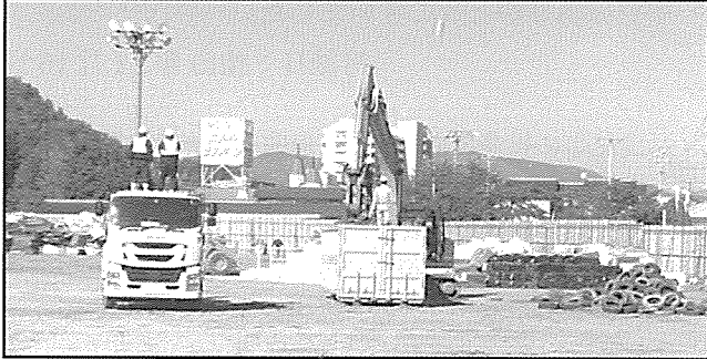
2019/11/13 積み込み作業
