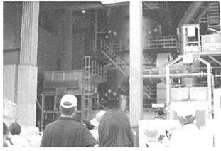
乾留ガス化炉を見学
