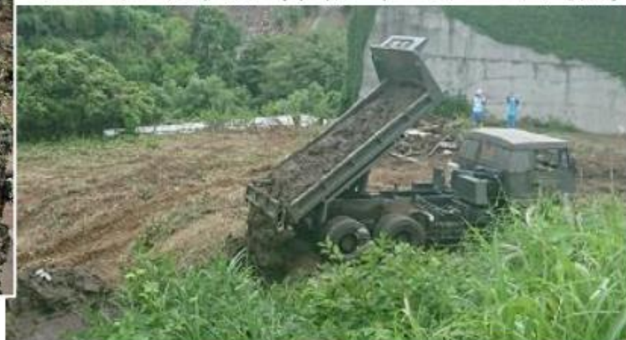
環境省撮影 大黒崎清掃工場跡地仮置場 自衛隊搬送状況 (令和3年7月7日時点)
