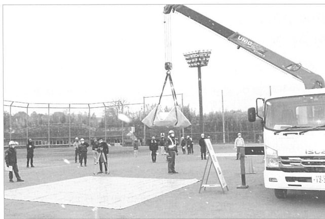
災害廃棄物の搬出訓練
