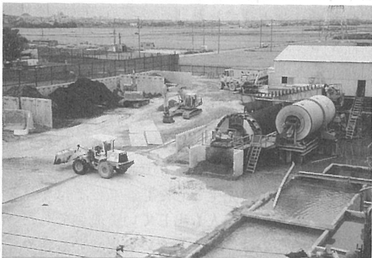
社名/村上技建株式会社 所在地/愛知県海部郡飛島村新設11-27 代表者/村上 治 設立/昭和47年 従業員/45名 TEL/05675(5)3111 事業所/本社、名古屋事業所、管理センター 営業種別/収集運搬、中間処理(脱水) 取扱品目/汚泥、建設廃材
