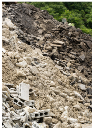
収集されたアスファルトがらやコンクリートがらは、リサイクルプラントで破碎される
