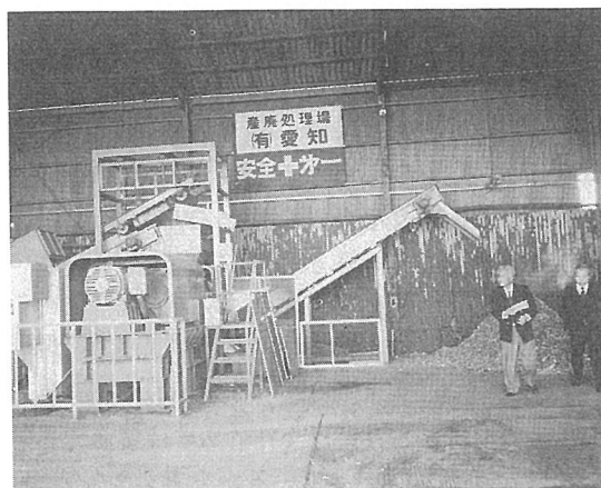
中間処理施設
