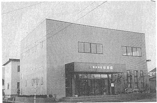
社名/株式会社杉浦組 所在地/愛知県半田市郷中町2-22 代表者/杉浦善一 創業/昭和39年 従業員/14名 TEL/0569(23)0811 事業所/本社 営業種別/収集運搬、中間処理(脱水、破碎) 取扱い品目/汚泥、建設廃材
