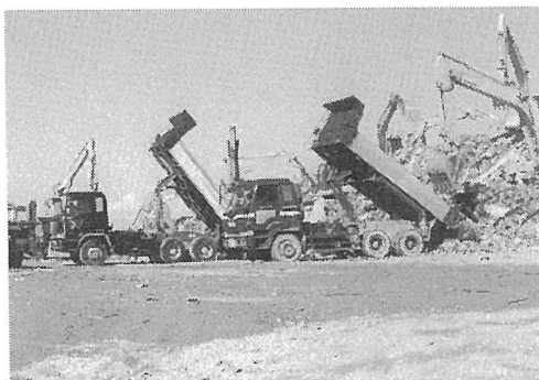
西枇杷島町などから次々に運びこまれる廃棄物
