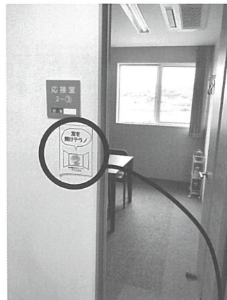
壁には3密回避啓発ポスター貼付窓と扉は開放した状態で使用
