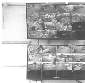
監視カメラのモニター
