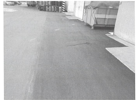
グレーチングを埋設した場内
