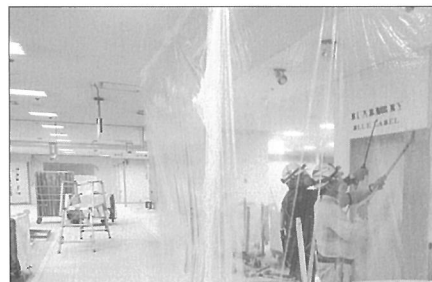
解体時における石綿除去作業
