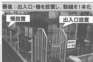
図2 段差のある作業の動線に手すり付き出入口を設置
