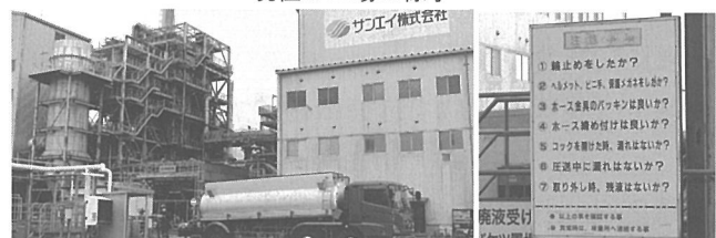
工場の外観(一部) 150t/日の溶融炉を保有
