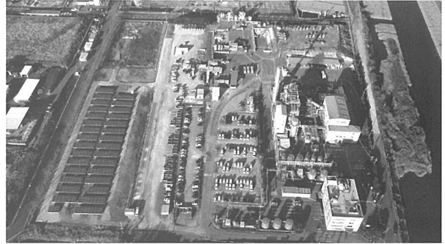
太陽光パネル(左側)及び環境事業部社屋(右側)の空撮写真
