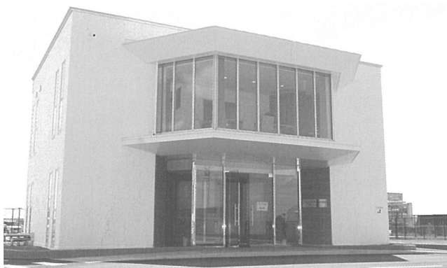
愛知第七工場（半田）事務所棟
