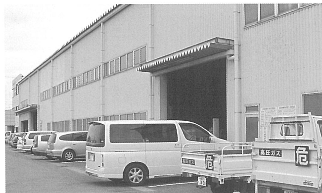
精製設備が入った豊橋リサイクルセンター(株)倉庫
