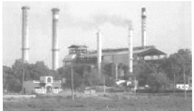
インド/バガス発電プラント
