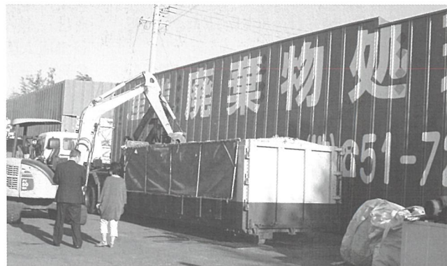
建設廃材を中心に分別、破碎を行う中間処理施設
