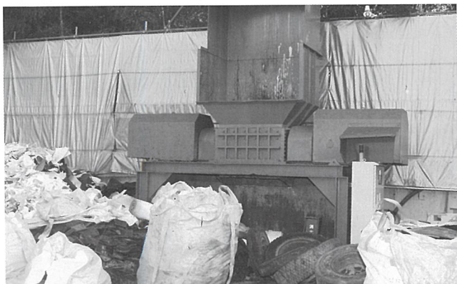
木くず、廃プラスチック類、石膏ボードなど分別、選別し、資源化する破碎施設
