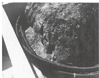
床下地中にクールチューブを敷設
