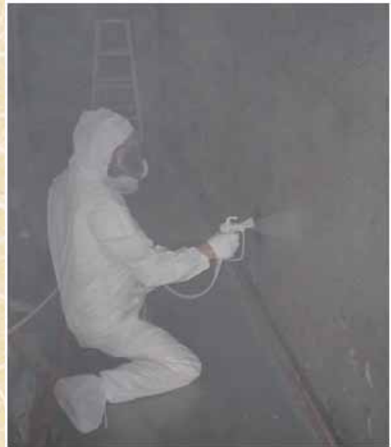
図 3.63 粉じん飛散抑制剤の散布による湿潤化
